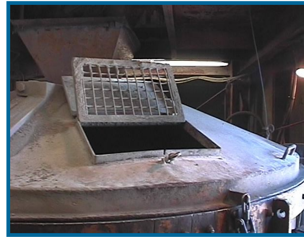
Planta de prefabricados
