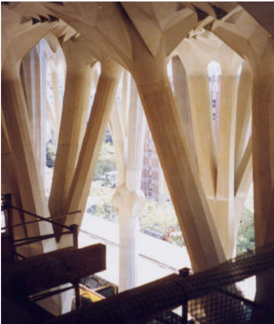
Acabado de las columnas de hormigón blanco de alta resistencia
