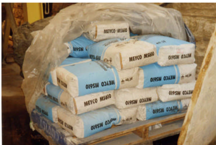
Sacos de MEYCO MS 610 en la obra
