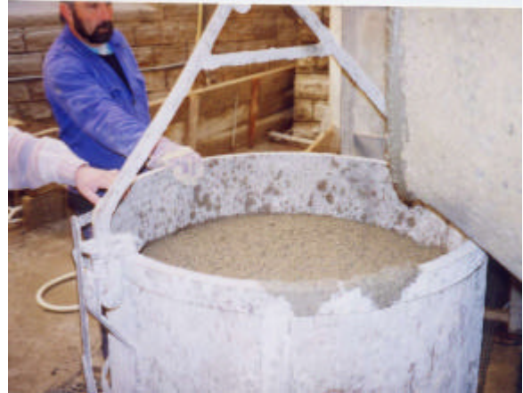
Hormigón líquido autonivelante
