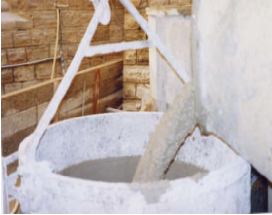
Descarga de la amasadora en el cubilote
