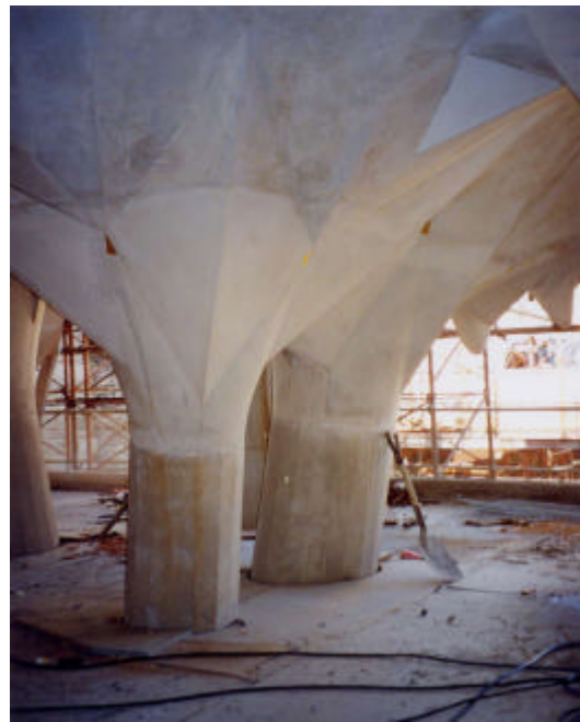
Acabado de las columnas de hormigón blanco de alta resistencia
