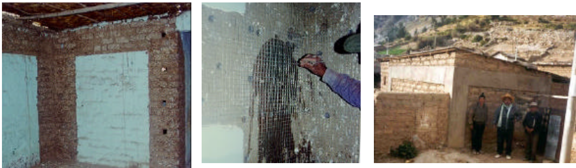
Figura 3. Etapas del reforzamiento en viviendas existentes. Eliminación del tarrajeo y perforaciones en el muro (izquierda), instalación de conectores y malla (centro) y tarrajeo final (derecha).
