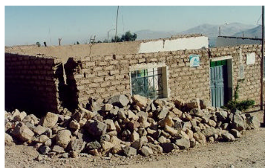
Figura 6. Colapso total y daños severos producidos por el sismo del 2001 en las viviendas de adobe carentes de refuerzo en Moquegua.
