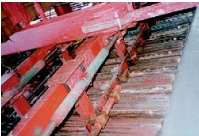
Foto 7: Detalle de columna fundida, deslizamiento de la formaleta.
