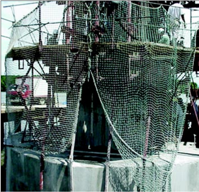
Foto 5: Sistema de la formaleta deslizante
