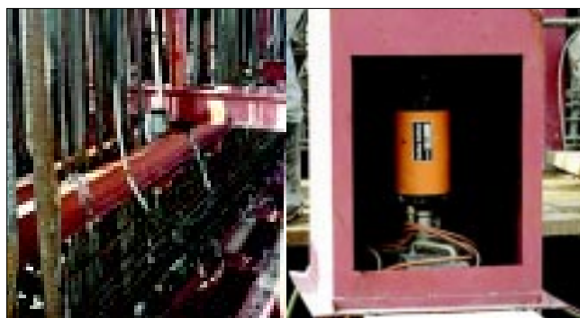
Fotos 1 y 2: Equipo hidráulico para elevar la formaleta.
