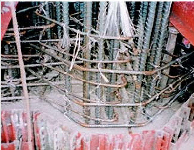
Foto 6: Detalle armado de hierros de las columna, para fundición
