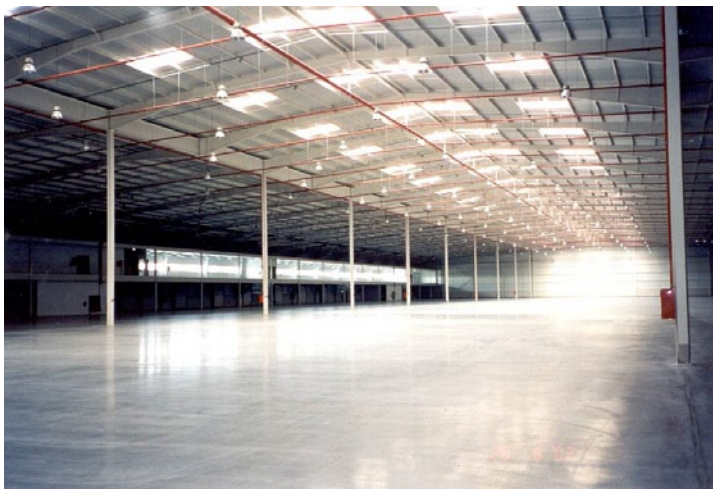
Fig3. Almacén Industrial – Losa Reforzada con Fibras de Acero Wirand
