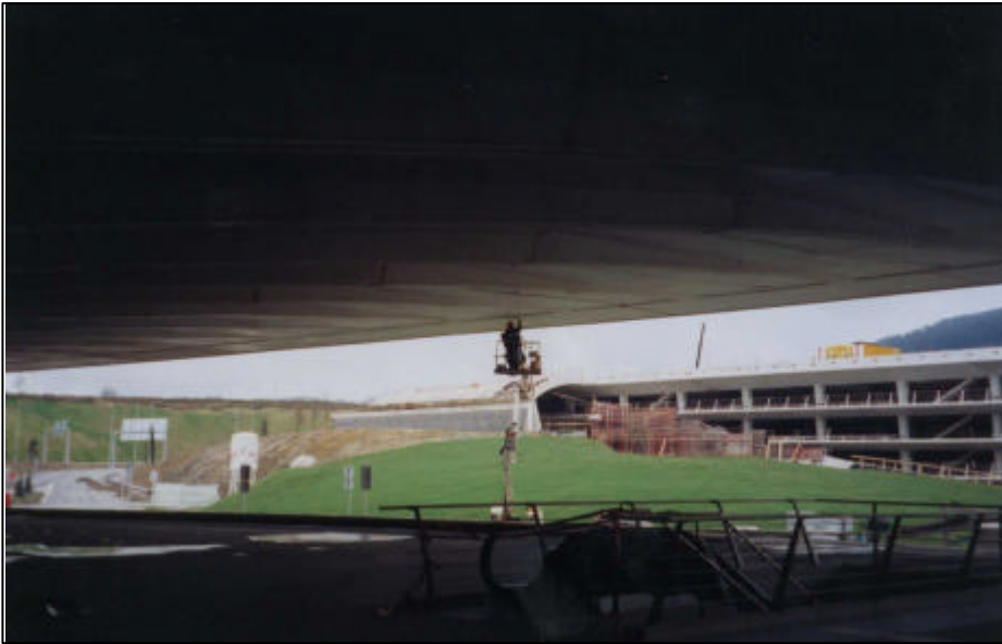
Vista bajo el voladizo posterior de la terminal del aparcamiento en construcción
