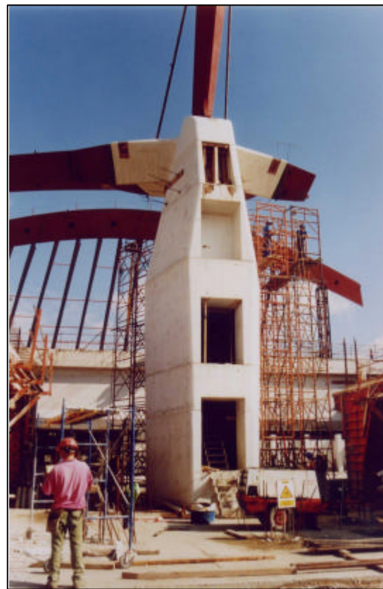
Detalles de la evolución de los trabajos, en los que se aprecia el hormigón blanco
